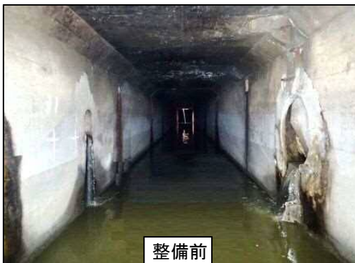
老朽化対策（管きよ更生工法）[別所幹線]
