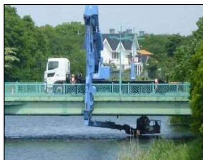
橋りょう点検車による点検
