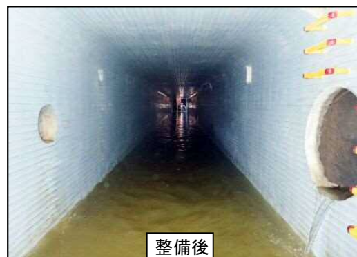
老朽化対策（管きよ更生工法）[別所幹線]
