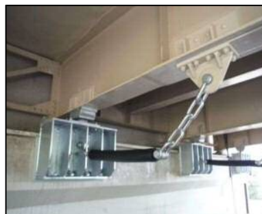
落橋防止装置の取付
